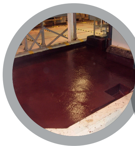
Обваловка химических хранилищ
